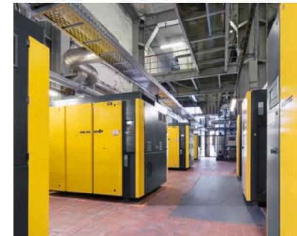
En la estación de aire comprimido hay instalados cuatro compresores de tornillo con el eficiente PERFIL SIGMA y motores IE4.
