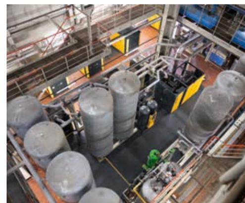
Dos sistemas de tratamiento diferentes secan el aire comprimido al nivel necesario para su uso.
